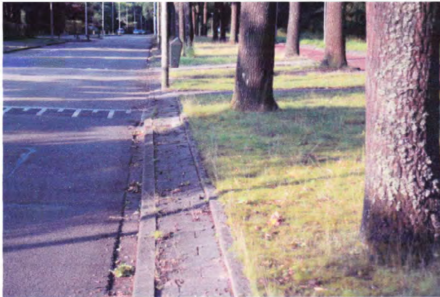
Foto 5 Tegerverharding aan rijbaanzijde, zie profielkuil 1
